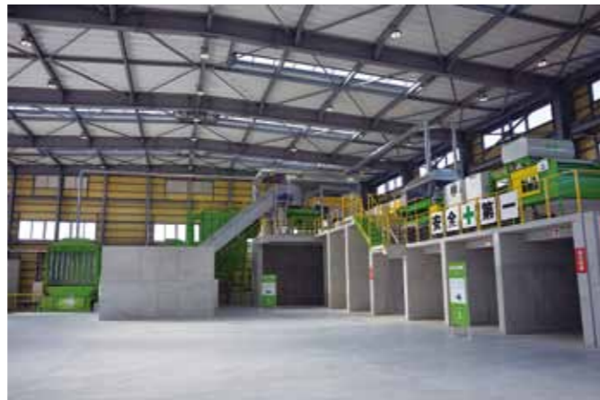
▲マテリアル棟・Aライン全景
