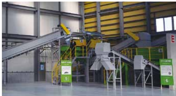
▲マテリアル棟・Bライン選別部
